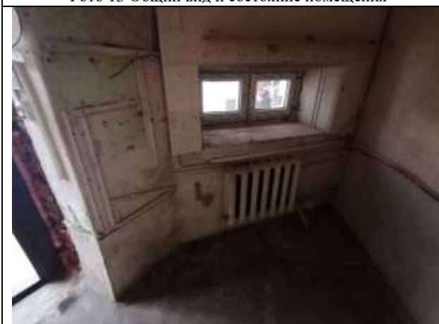
Фото 15 Общий вид и состояние помещения, окно
