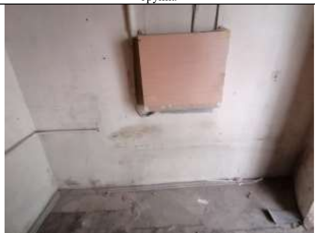
Фото 14 Общий вид и состояние помещения
