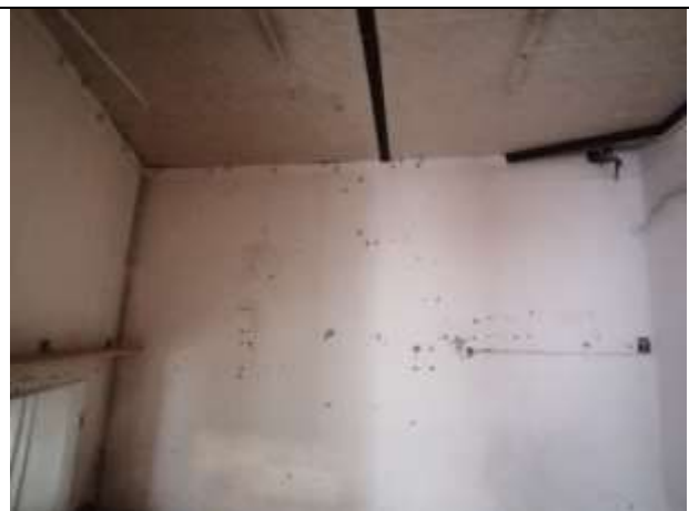
Фото 10 Общий вид и состояние помещения
