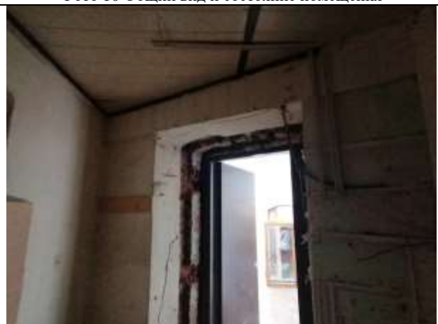
Фото 12 Общий вид и состояние помещения, входная группа
