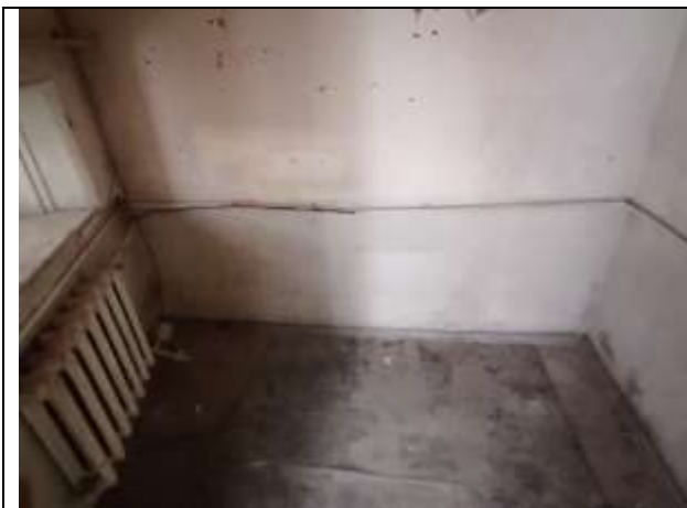
Фото 9 Общий вид и состояние помещения
