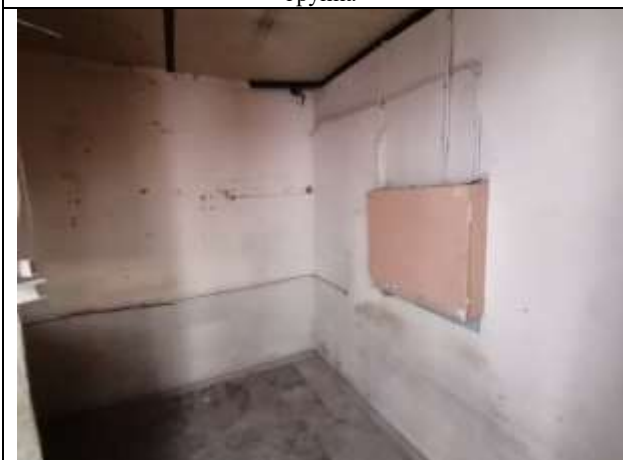
Фото 13 Общий вид и состояние помещения
