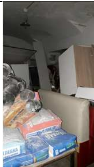
Фото №32 Внутреннее состояние Объекта оценки
