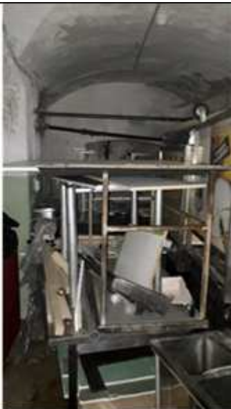
Фото №13 Внутреннее состояние Объекта оценки
