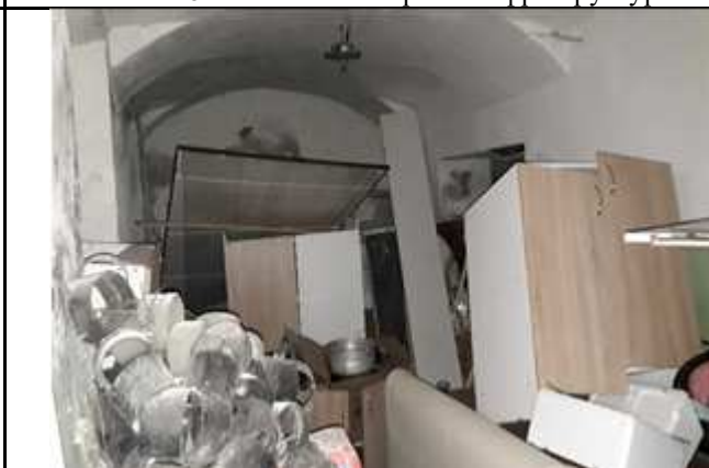
Фото №30 Внутреннее состояние Объекта оценки
