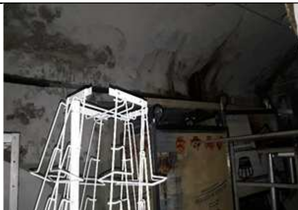
Фото №20 Внутреннее состояние Объекта оценки
