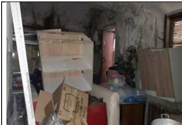
Фото №25 Внутреннее состояние Объекта оценки
