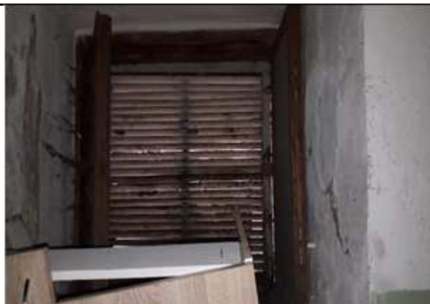
Фото №26 Оконный проем Объекта оценки
