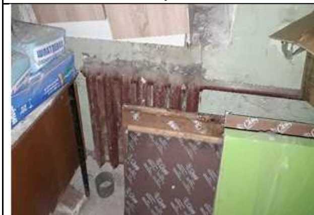
Фото №29 Элемент инженерной инфраструктуры
