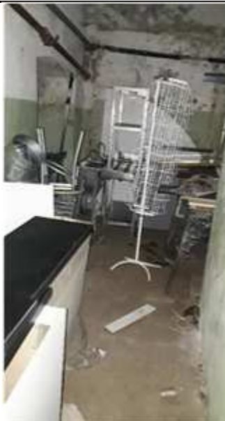
Фото №18 Внутреннее состояние Объекта оценки
