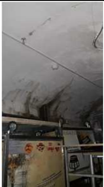
Фото №15 Внутреннее состояние Объекта оценки
