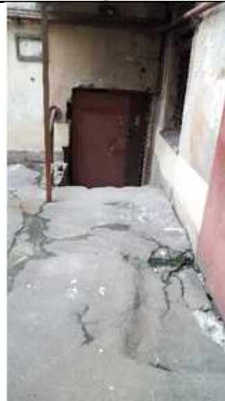
Фото №10 Вход в соседнее помещение
