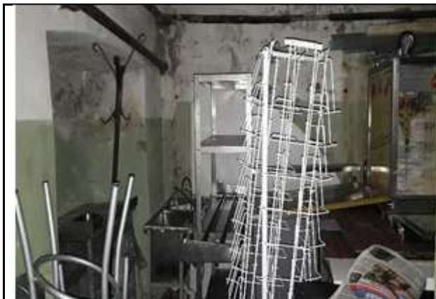
Фото №19 Внутреннее состояние Объекта оценки
