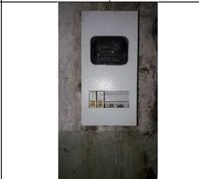
Фото №28 Элемент инженерной инфраструктуры
