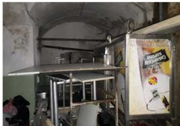
Фото №12 Внутреннее состояние Объекта оценки
