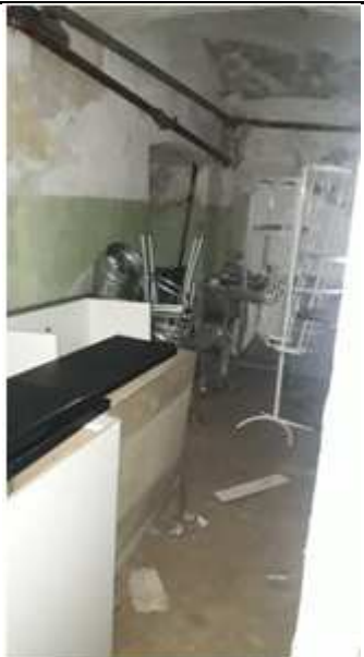
Фото №17 Внутреннее состояние Объекта оценки
