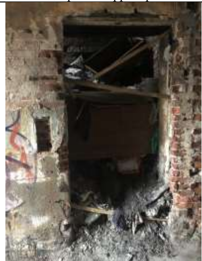
Фото 10. Состояние помещений Объекта оценки.
